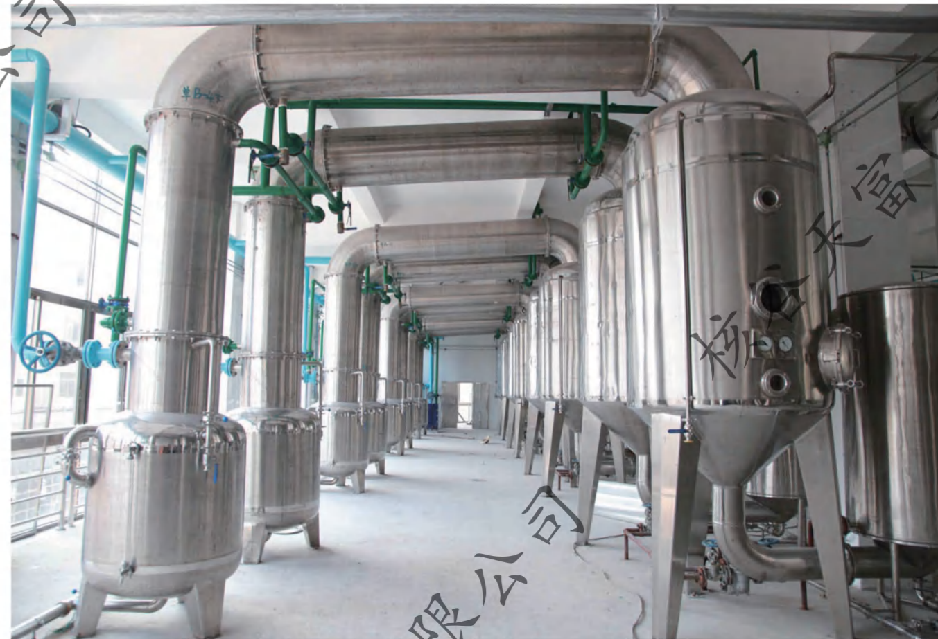
浓缩车间实拍图
